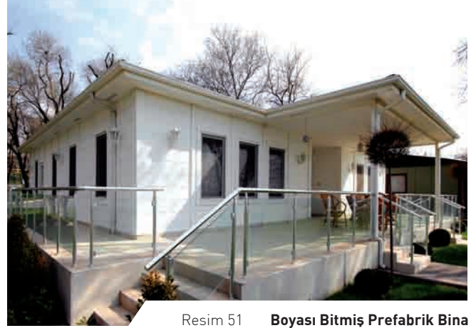
Resim 51 Boyası Bitmiş Prefabrik Bina
