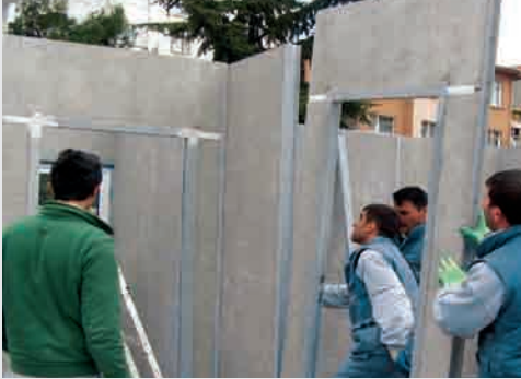
Resim 47 Prefabrik Bina İç Duvar Yapımı
