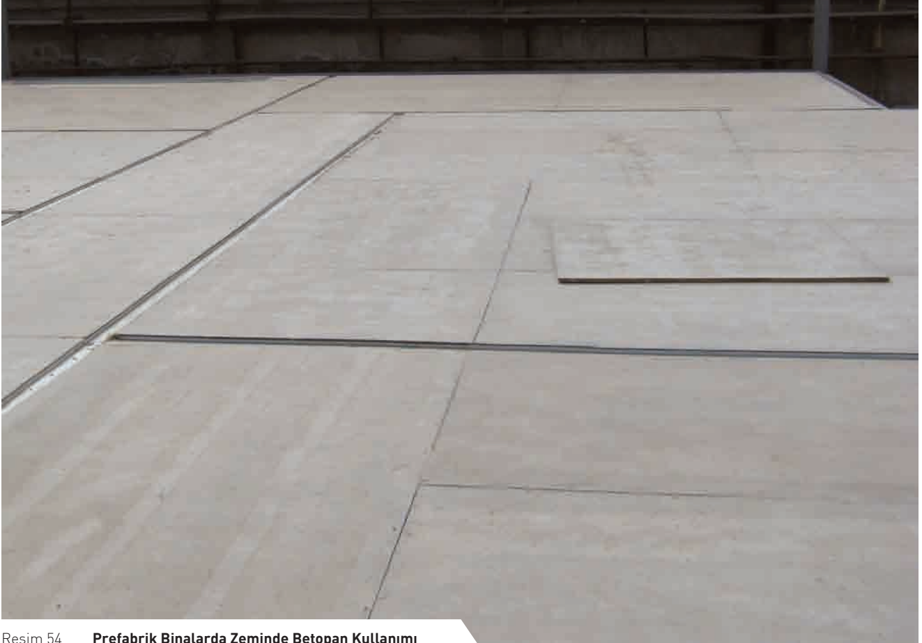
Resim 54 Prefabrik Binalarda Zeminde Betopan Kullanımı
