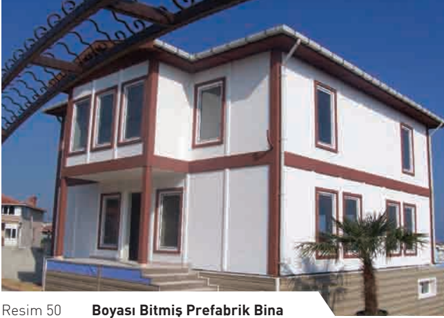
Resim 50 Boyası Bitmiş Prefabrik Bina
