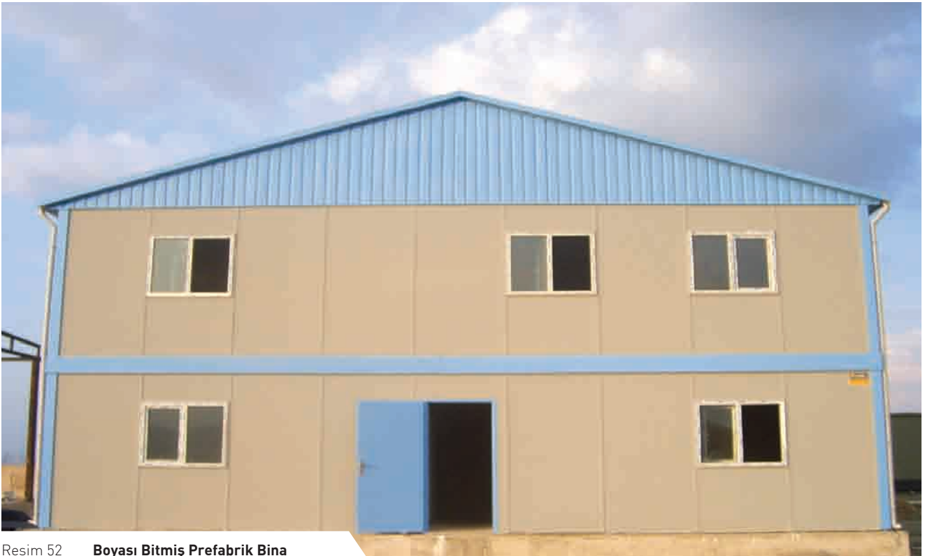
Resim 52 Boyası Bitmiş Prefabrik Bina
